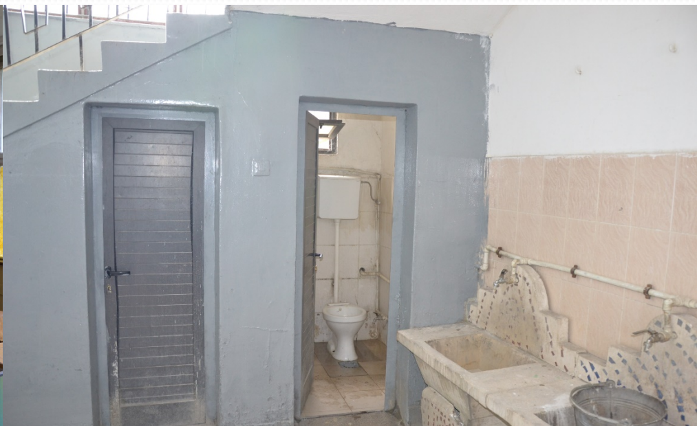
Slika 14: Sanitarije šole v Klini, Vir: Osebni arhiv
